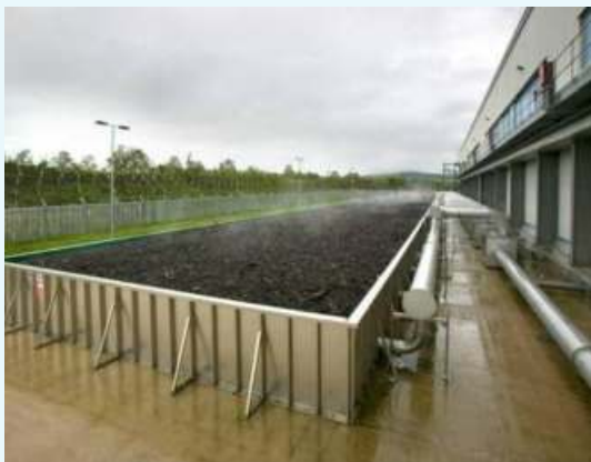
Biofiltrar (predviđena natkrivena izvedba)
