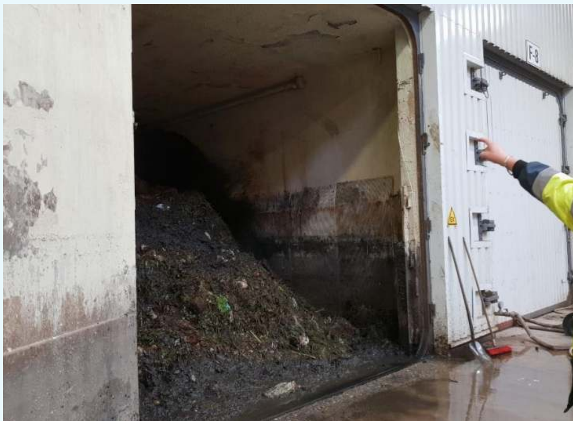
Tunel (fermentor) za aerobnu biološku obradu
